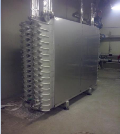
Schlamm / Wasser 16 m 3 /h
